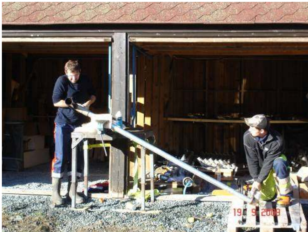
Byggland og Grønlid monterar røyrdelar
